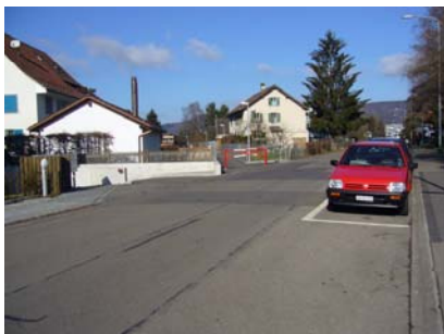
Bild 4: gute verkehrsberuhigende, querschnittsreduzierende Massnahme an der alten Schützenhausstrasse
